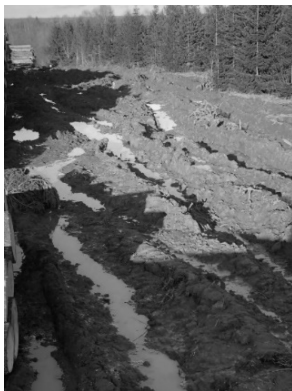
Рис. 1. Образование колеиности на погрузочном пункте Fig. 1. Formation of rutting on loading construction
